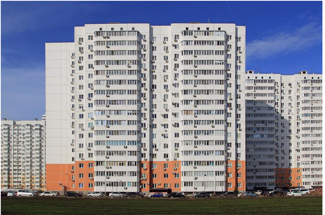
Рис. 9. Фотографирование фасадов зданий с разных ракурсов.
