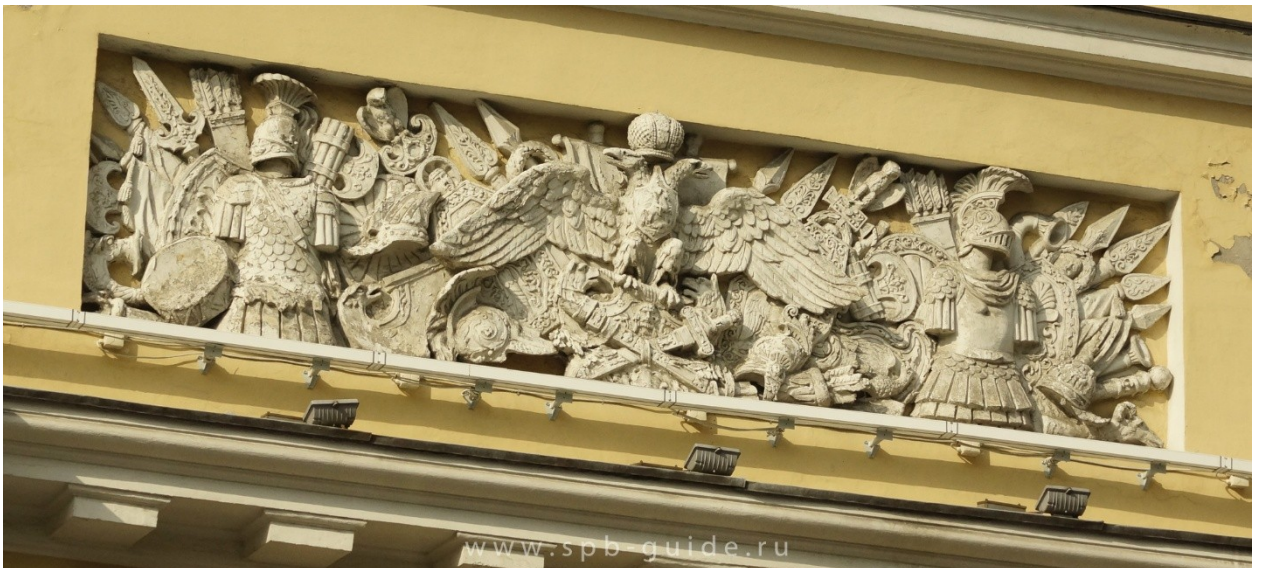
Рис 17. Арматура в кессоне фасада Военно-топографического училища. Русский классицизм.
