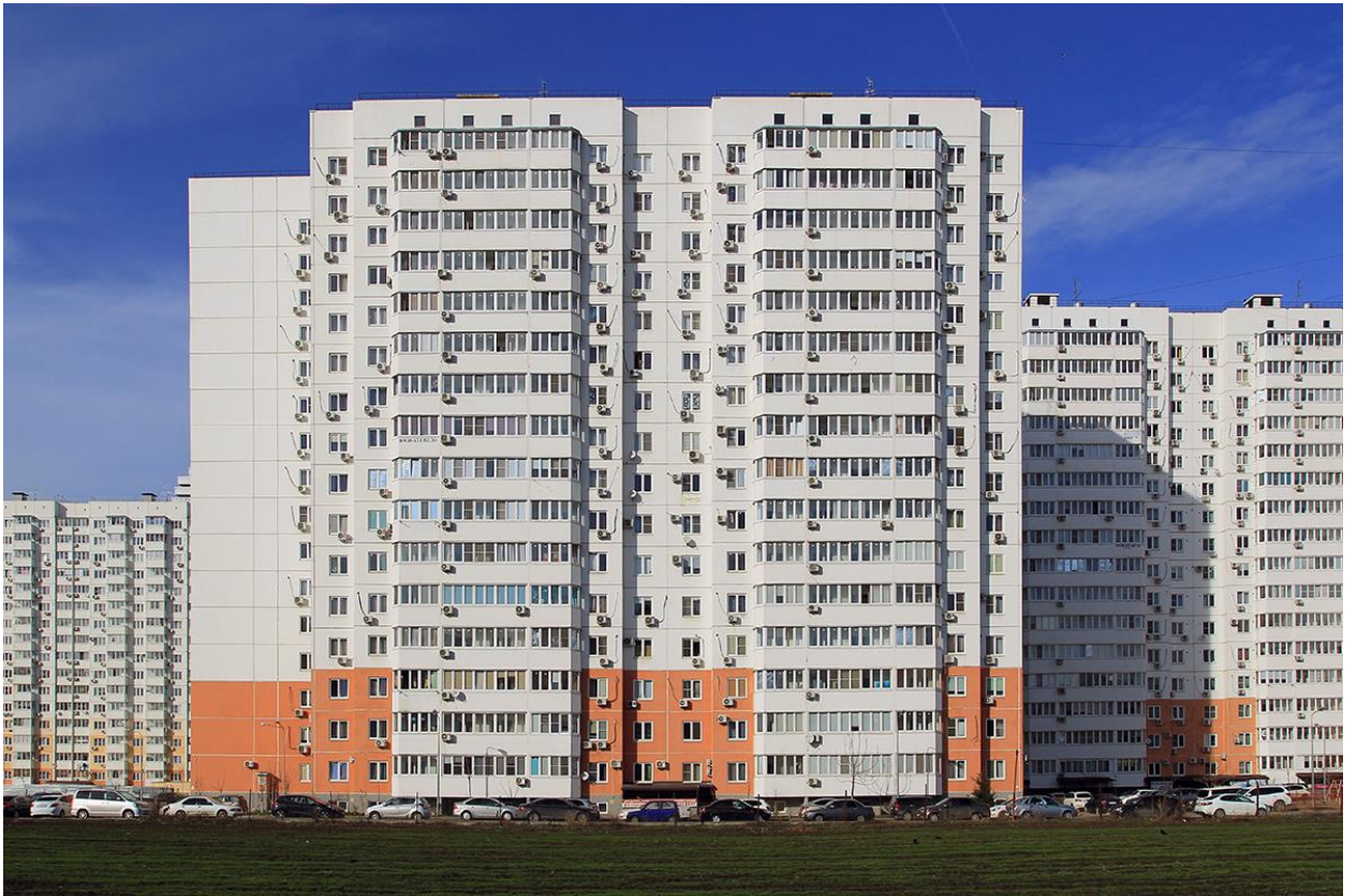
Рис. 9. Фотографирование фасадов зданий с разных ракурсов.
