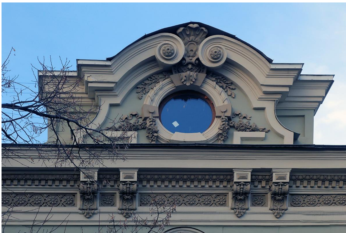
Рис 7. Архитектурные элементы (Люкарна, карниз, модульоны, дентикулы, розетки, волюты).
