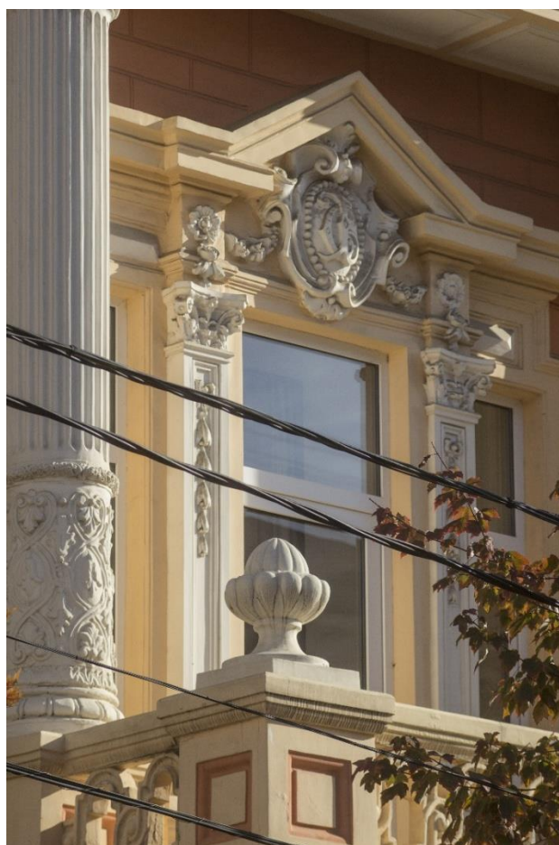
Рис 8. Архитектурные элементы (Пилястры, балкон, колонны, каннелюры, шишка, картуш, сандрик, розетки, рустика, карнизы, кессоны, рустика)
